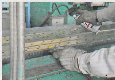
ซ่อมการป้องกันสนิมสำหรับการก่อสร้างนั่งร้าน
